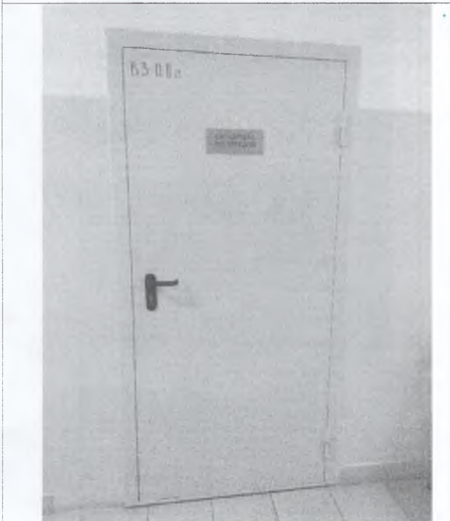
Фото №3. На дверях помещений производственного и складского назначения имеются категории по взрывопожарной и пожарной опасности.
